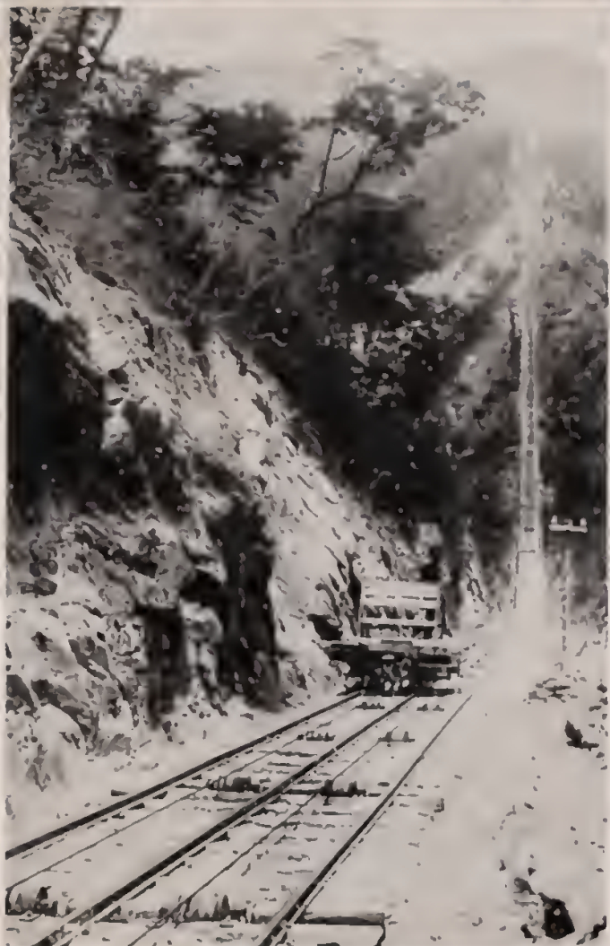
インフライン線路 七畝橋橋、リ急勾配一割五分 絶頂・白雲山海抜一千有餘尺ノ高嶺地
